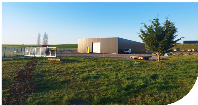
Installation de l'entreprise BLAISIN TP
